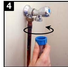
Otvorte kohútik na prívode vody. Skontrolujte, či voda nevyteká tam, kde nemá. Hadicu na prívod vody nemožno predĺžiť. Ak je príliš krátka, kontaktujte popredajný servis.
